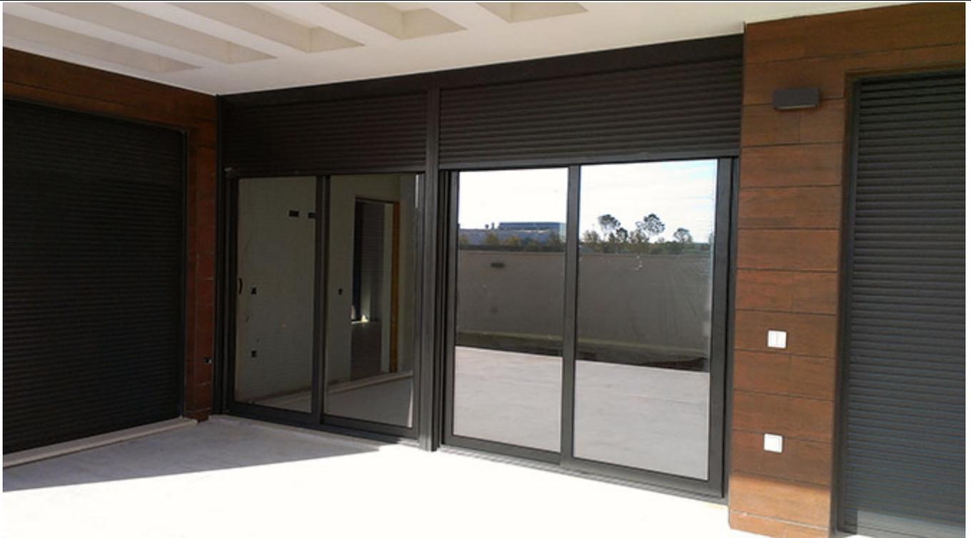
Aquí se eligieron las carpinterías con Rotura de Puente Térmico de **ITESAL**. En concreto, la serie Corredera Perimetral **80 RPT** en el exterior, con vidrio **GUARDIAN-SUN**, y la serie **IT-61 RPT** en la división de espacios en la piscina interior, con vidrio **CLIMAGUARD**.
